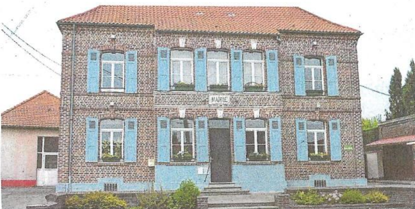
Des travaux dans la mairie sont prévus d'ici octobre
