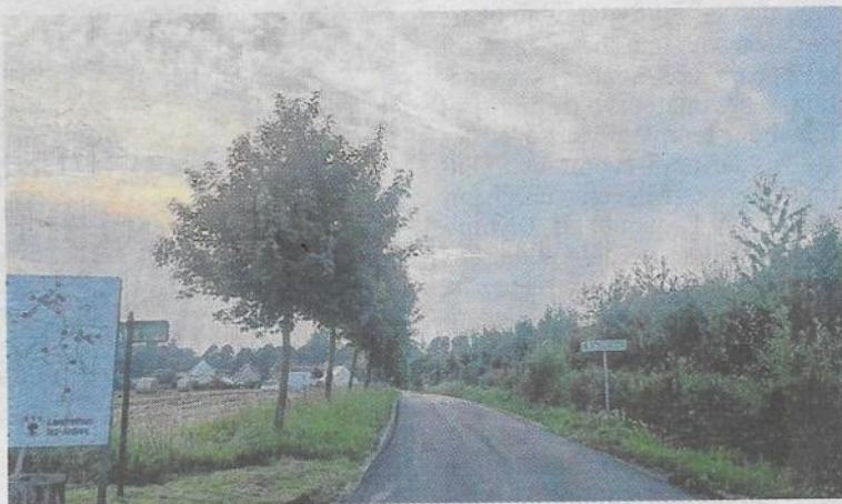
Cette intervention avait pour but de raccorder les nouveaux revêtements de voirie à ceux déjà existants.
